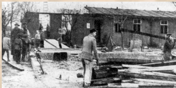
Barackenlager in Telgte: Abrissarbeiten 1959
